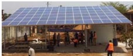
Instalaciones Fotovoltaicas híbridas de conexión a red y autoconsumo: Instalación de 17 kW para dar servicio a instituciones públicas. Ubicado en Guinea Conakry
