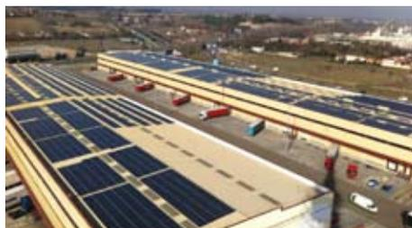
INSTALACIÓN SOLAR FOTOVOLTAICA DE 2,5MW SOBRE CUBIERTA DE NAVE INDUSTRIAL. ACTUALMENTE UNA DE LAS MAS GRANDES DE ESPAÑA DE ESTA TIPOLOGIA.
