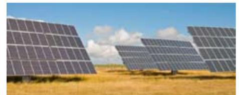
Instalaciones Fotovoltaicas con seguidores de conexión a red: Instalaciones fotovoltaicas de 100kW con conexión a red con seguidores a dos ejes. Ubicación Papatrigo (Ávila).
